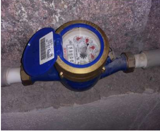
Toplu iğne ile Müdahale Edilmiş Su Sayacının Değişimi
