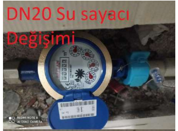
Toplu iğne ile Müdahale Edilmiş Su Sayacının Değişimi
